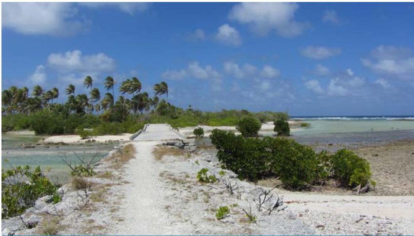
Zniszczony most na wyspie South Tarawa, fot. Flexman, CC BY-SA 3.0
